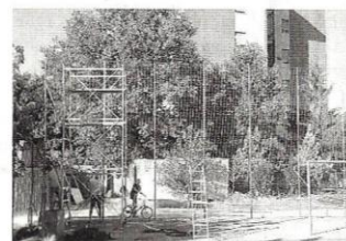
I lavori nella struttura oratoriana
